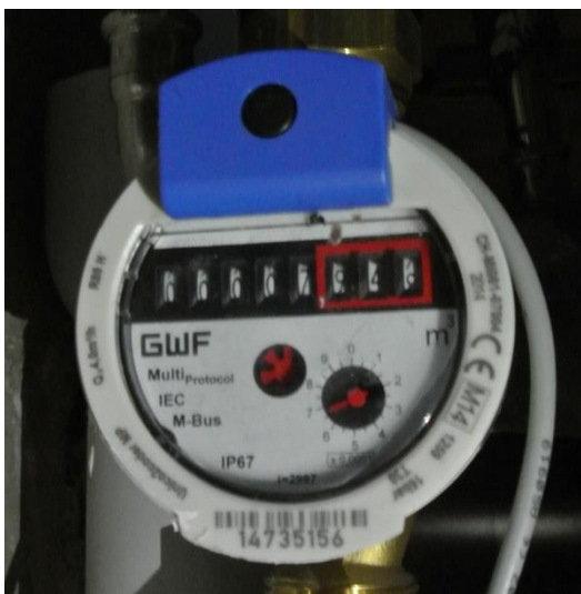
Bild 8-46: Kaltwasserzähler enthärtet E-Kombidämpfer Rational Typ 101 1, 06.07.2015 14:07
