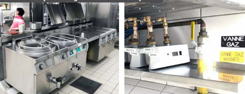
Instalacja licznika gazu w kuchni szkolnej.
