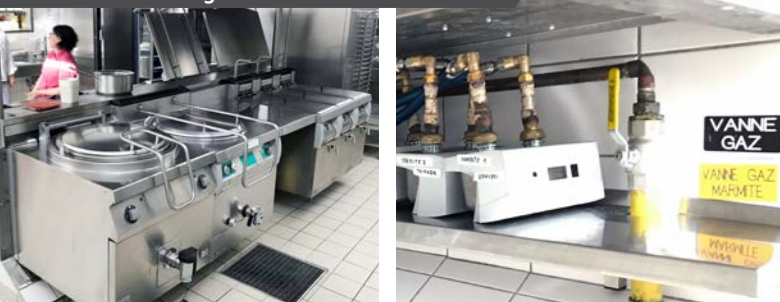
Installation av gasmätare i skolkök.
