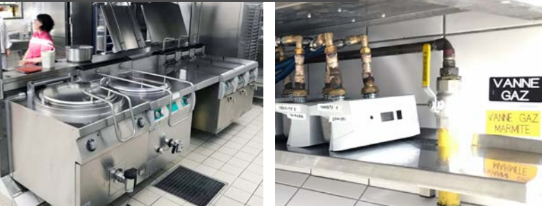
Okul mutfağında gaz sayacı kurulumu.
